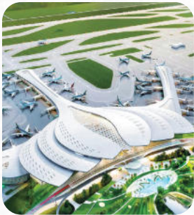
Dự án Sân bay quốc tế Long Thành
