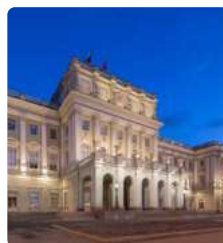
Công trình xây dựng
