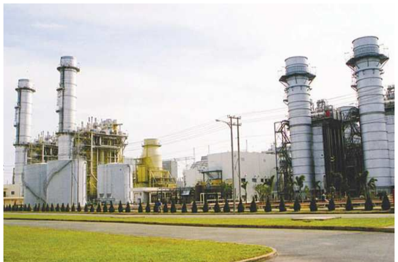
Nhà máy nhiệt điện Phú Mỹ
